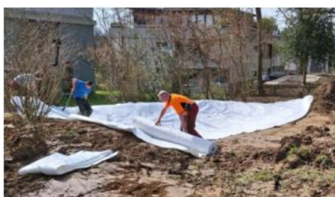
Abdichtung mit 2 Schutzzvlies
